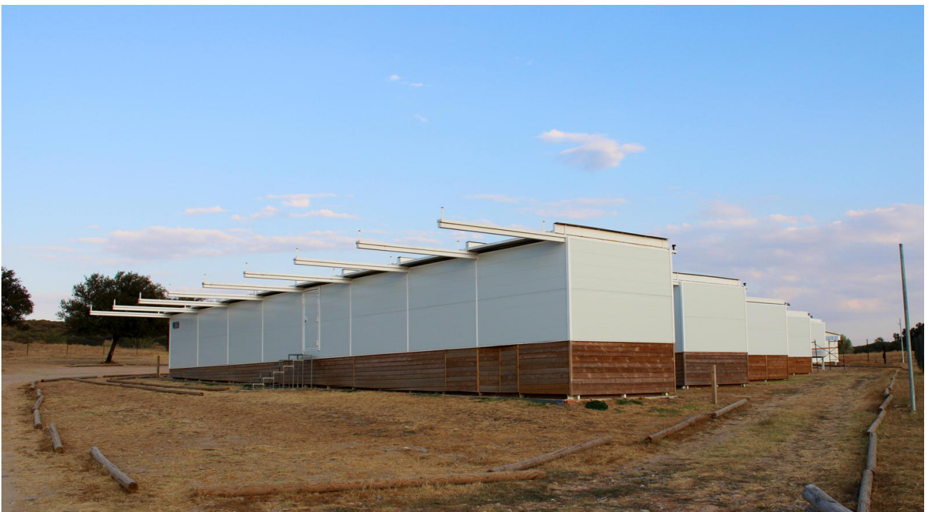
Abbildung 5: E-EyE Observatorium nahe Fregenal de la Sierra in der Extremadura, Spanien. Das Observatorium besteht aus mehr als 60 einzelnen Teleskopsystemen, die von Universitäten, Forschungseinrichtungen und Amateurastronomen betrieben werden. Jedes System ist in einem der acht Segmente der abgebildeten Beobachtungsgebäude untergebracht. Jedes Segment hat ein individuell gesteuertes Rolldach und eine Wetterüberwachung, die mit dem Kontrollsystem des Teleskops verbunden sind.
